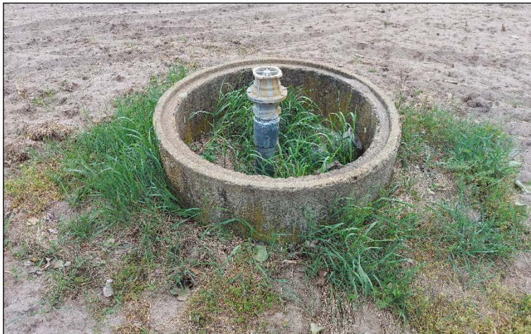
Abbildung 15: Teil eines ehemaligen Bewässerungssystems (25.05.2022)
