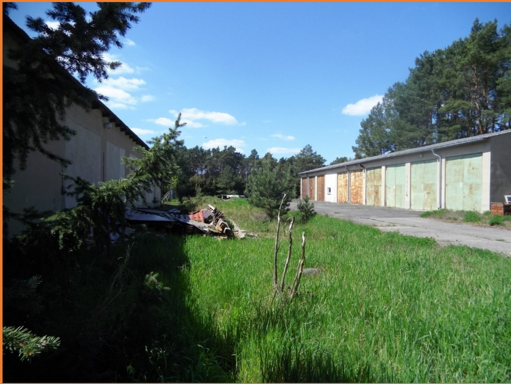
Abb. 3: Ehemaliges Betriebsgelände der Meliorationsgenossenschaft Luckenwalde
