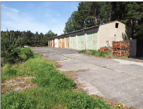
Foto 5: Untersuchungsraum im mittleren Teil
