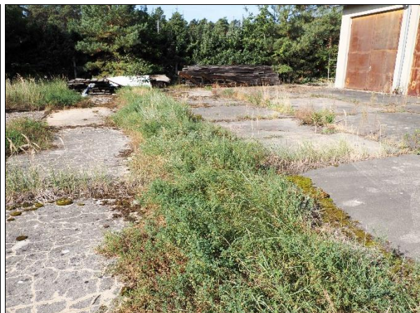
Foto 6: Untersuchungsraum im mittleren Teil
