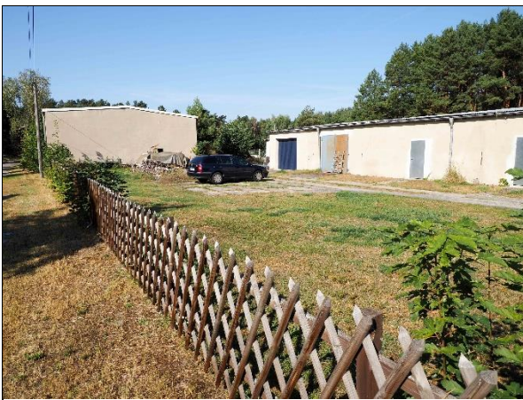
Foto 9: Untersuchungsraum im südlichen Teil
