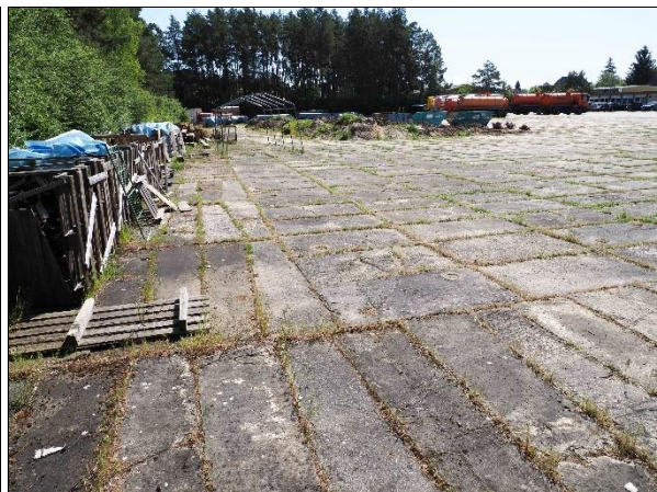
Foto 4: Untersuchungsraum im nordwestlichen Teil
