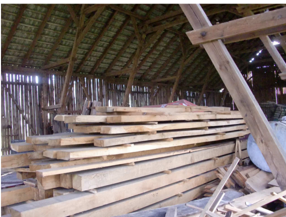
Alte Scheune, die noch als Lagerplatz genutzt wird.
