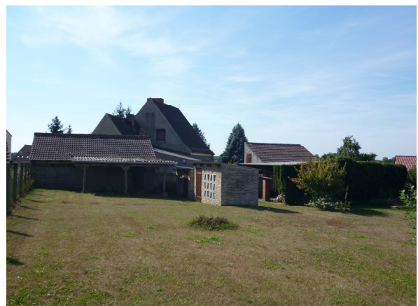
Die Nebengebäude bieten eventuell Quartiere für Fledermäuse.
