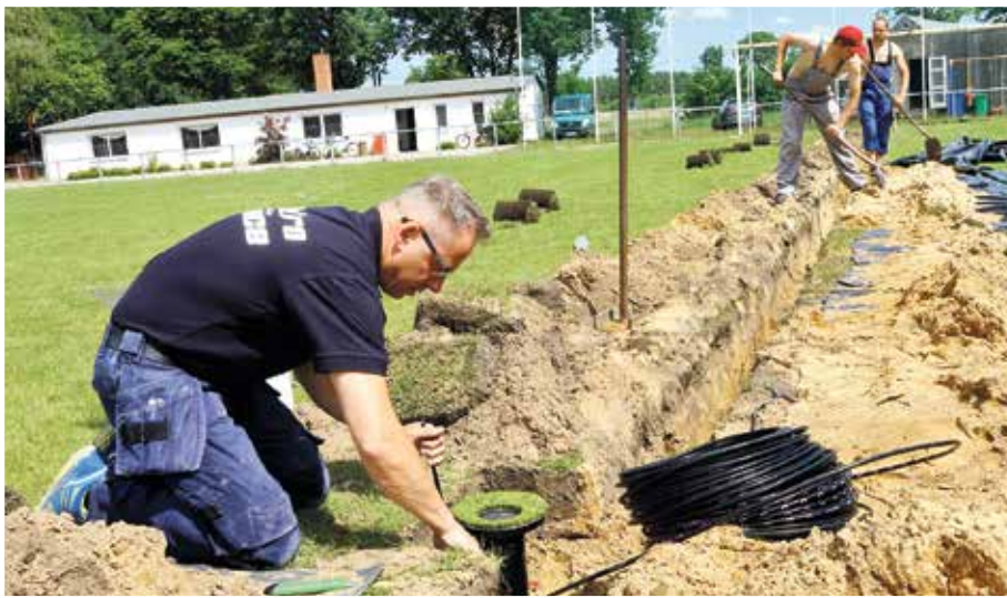
Einbau der Beregnungsanlage
