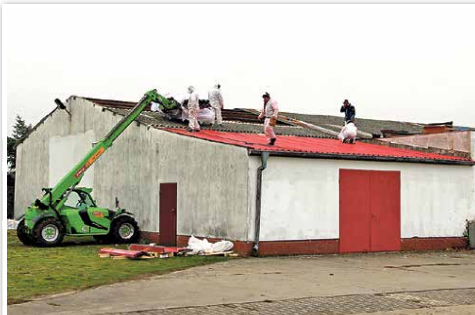
Die alten Asbestplatten auf der Fahrzeughalle der Feuerwehr in Dobbrikow wurden Ende 2018 entfernt und durch Trapezprofilbleche ersetzt.
