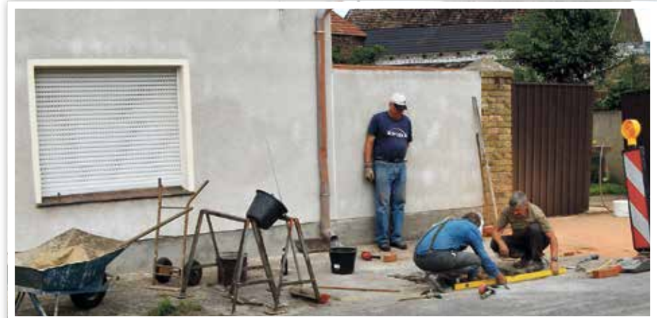
Mit vereinten Kräften ist man in Lynow dabei, einen Abwassersammelschacht wieder funktionstüchtig zu machen.
